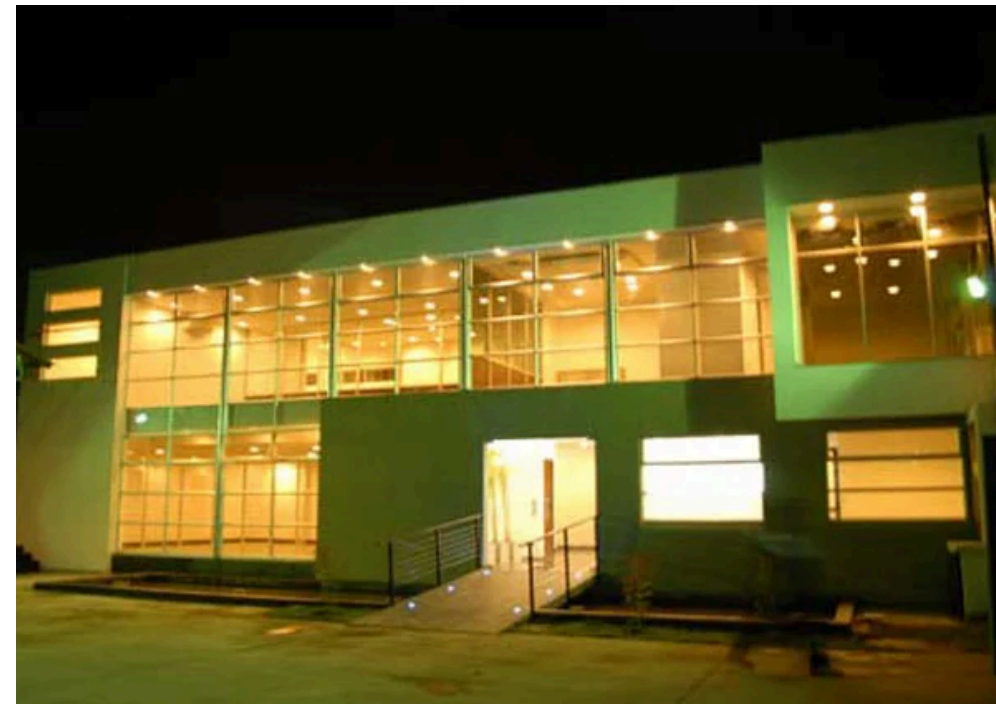
Edificio Corporativo Global Courier Casa Matriz
